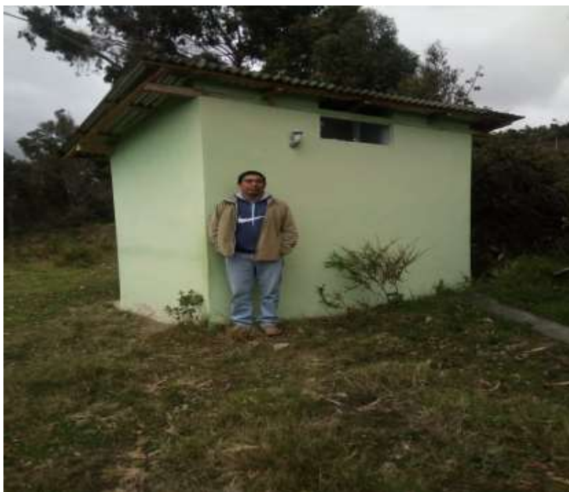
FOTO N° 02. - UNIDAD BÁSICA DE SANEAMIENTO PAMPA GRANDE.
