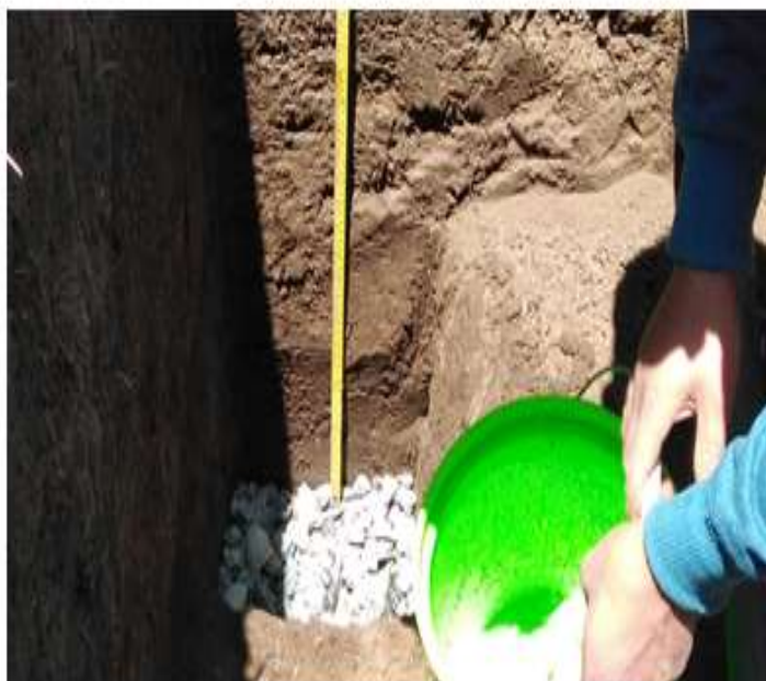
FIGURA N° 02: Colocación de la capa de grava fina de e=5\text{cm} .
