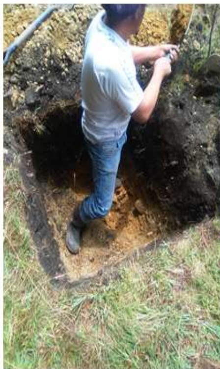
FIGURA N° 04: Excavación de la calicata 02
