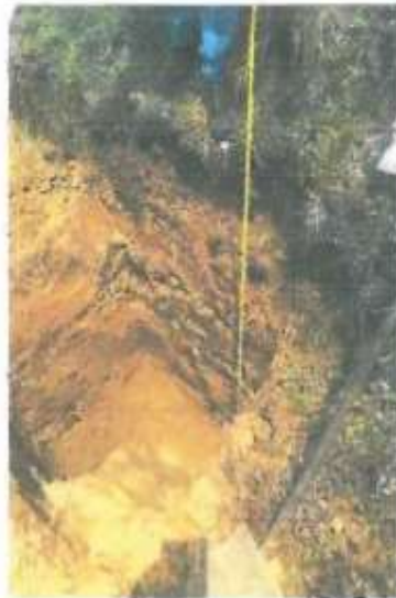
Calicata 5 : LINEA DE DISTRIBUCIÓN
