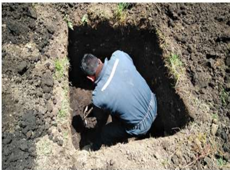
FIGURA N° 01: Preparación de la Calicata de 1m x 1m x 1m
