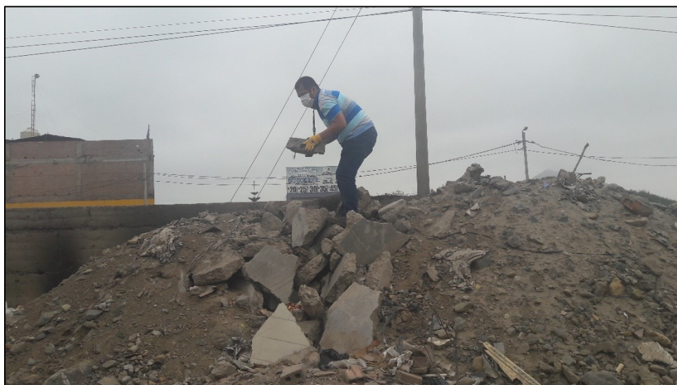
Fotografía N° 01: Recolección de Concreto de demoliciones.
