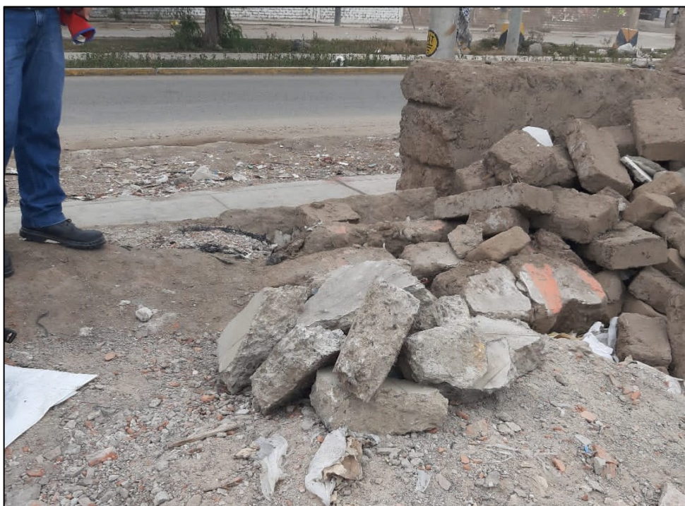
Fotografía N° 02: Selección de Concreto de demoliciones.
