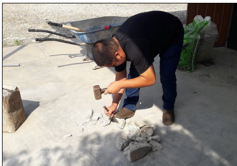
Figura 8: Trituración de los Residuos de Construcción
