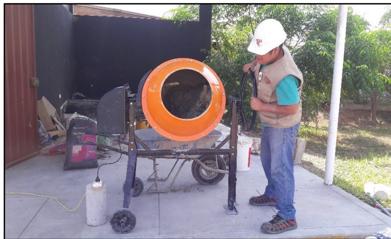
Figura 20: Elaboración de Concreto Reciclado.
